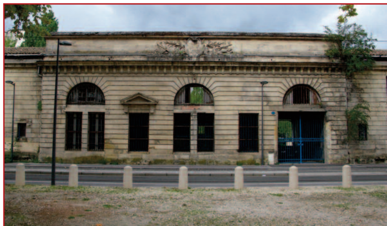
Façade du magasin aux vivres sauvegardée rue Achard
