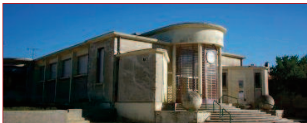
Anciens bains-douches et crèche, aujourd'hui bâtiments administratifs
