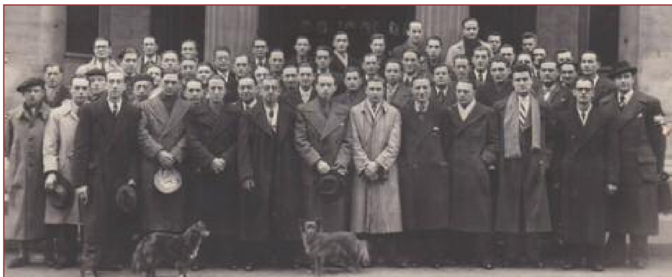
L'ensemble du personnel désigné pour le Service du Travail Obligatoire devant la façade du journal la France , rue Porte-Dijeaux
