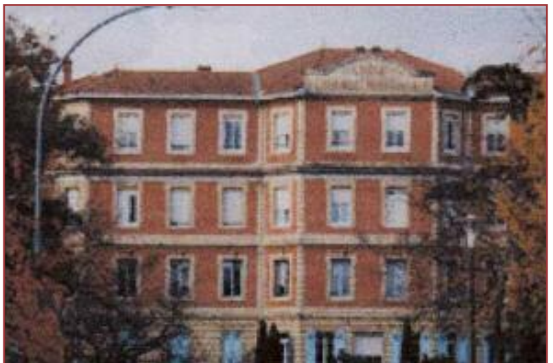
Domaine de Bagatelle, route de Toulouse, 201, rue Robespierre La maison principale après surélévation et agrandissement
