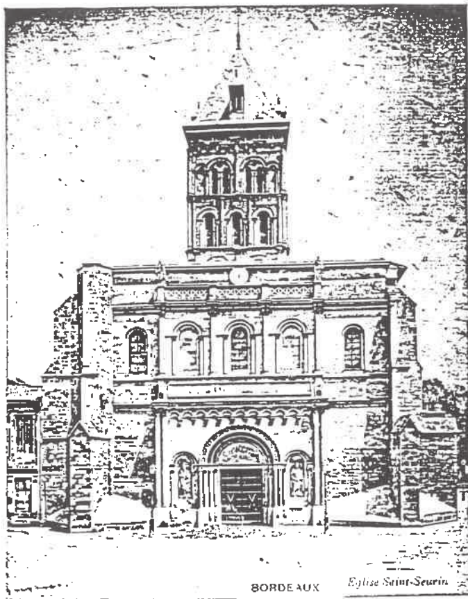
FACADE REFAITE EN 1829
